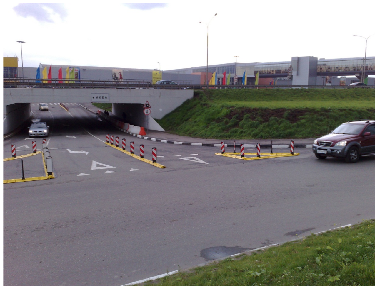
Рисунок 1.30 - Пример канализирования на пересечении с помощью делинаторов
