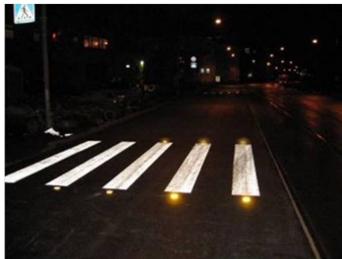
Рисунок 1.43 - Пример совместного использования дорожной разметки и световозвращателей
